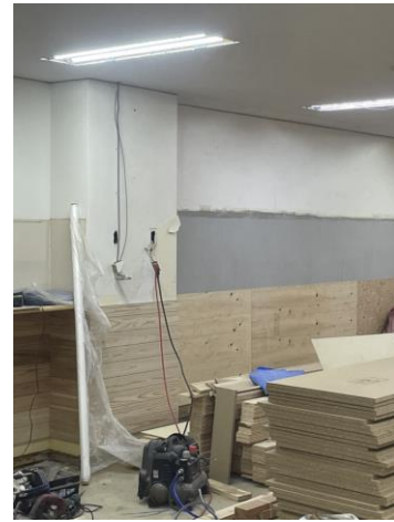
古い暖房機器と配管も 全てなくなりスッキリ
